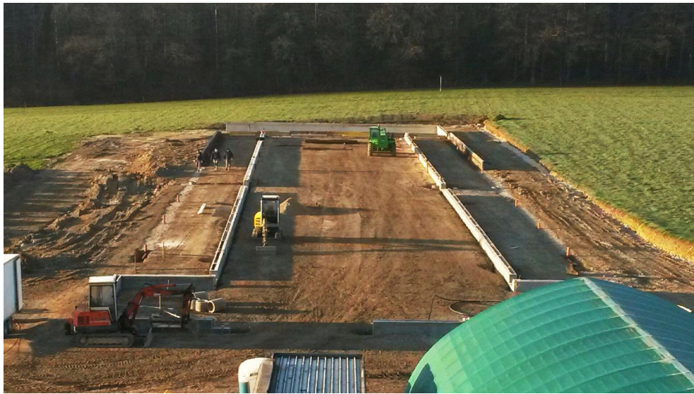
Bau des Hühnerstalls für 12 000 Legehennen in Céligny
