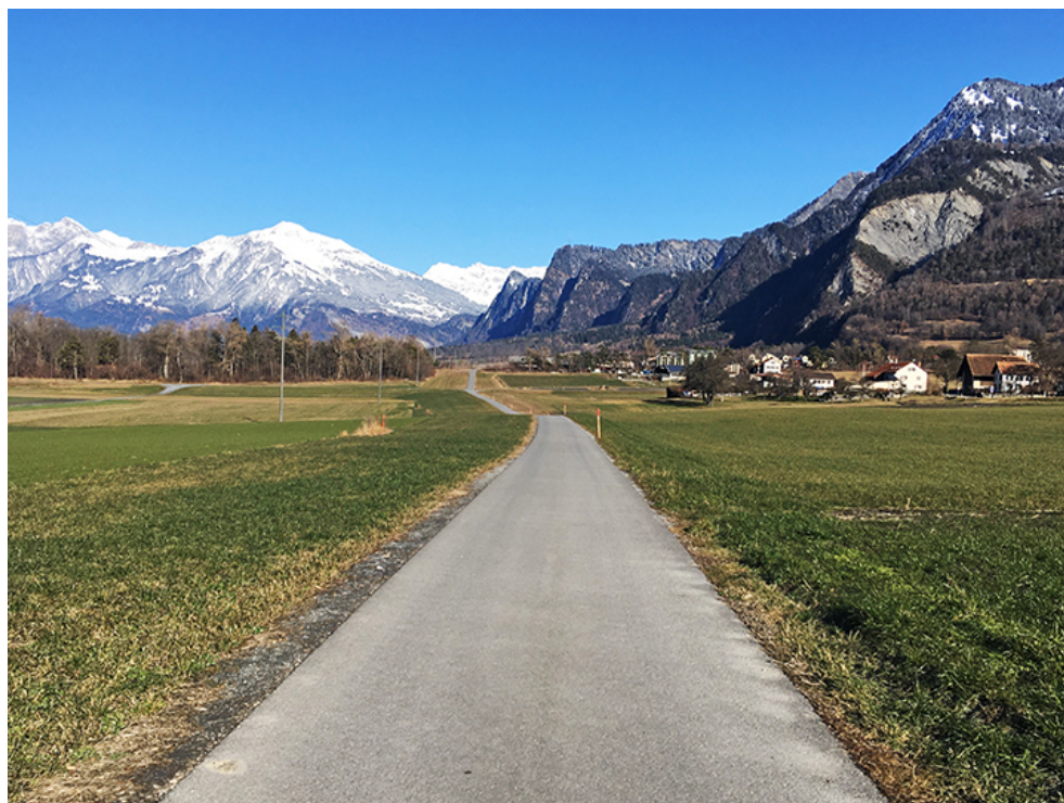
Nuova strada agricola costruita sul vecchio tracciato della corsia nord (contrassegnata in rosso), vista verso nord.
