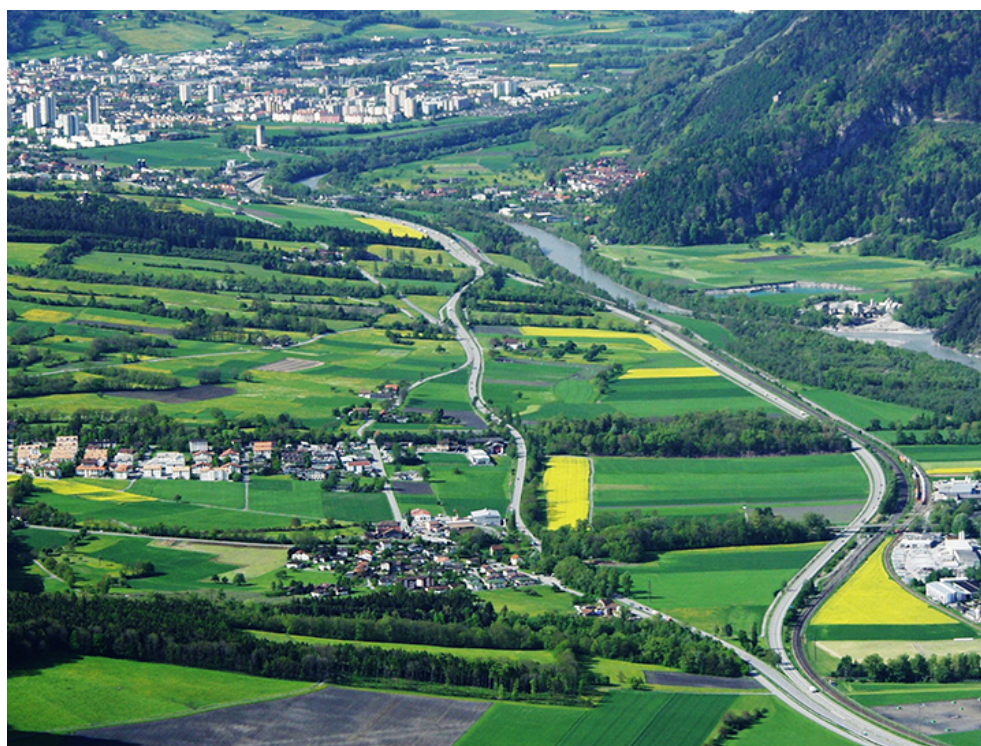
Strada nazionale A13 in corrispondenza della diramazione di Trimmis/Untervaz, vista verso sud.
